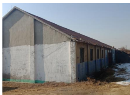
图 2-2 站南 40m，莱芜亿安生物 工程有限公司闲置车间
