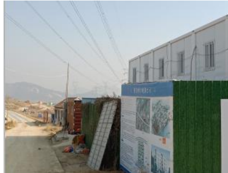
图 2-27 (2) 220kV 城鹏线 16#~17#， 线南 10m，施工板房
