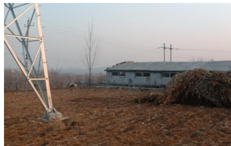
图 2-14 (2) 220kV 城汇线 41#~42#， 线南 13m，灰堆村看护房
