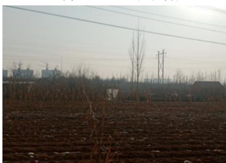
图 2-20 (2) 220kV 城汇线 3#~5#， 线下，大洛庄村看护房
