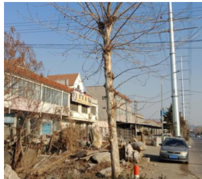
图 2-5（1）220kV 城汇线 99#~104#， 线北 11m，大增家庄沿街商铺/民房
