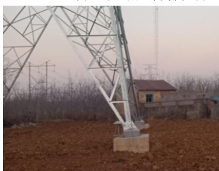
图 2-21 220kV 城汇线 1#~2#， 线下，王梁坡村看护房
