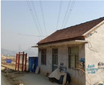
图 2-27 (1) 220kV 城鹏线 16#~17#， 线下，西峪村看护房
