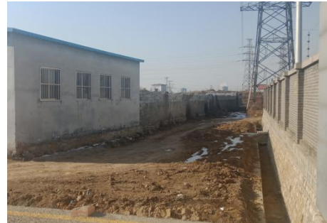
图 4-4 220kV 汇河站南侧
