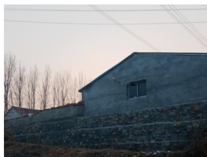
图 2-11 220kV 城汇线 57#~58#， 线下，林家庄村民房
