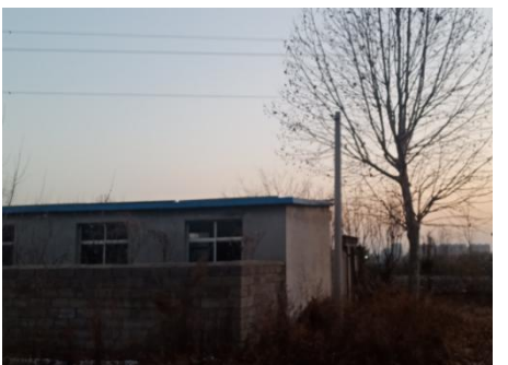
图 2-22 (1) 220kV 城鹏线 1#~2#， 线北 21m，王梁坡村看护房
