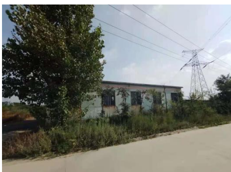
图 2-17 220kV 城汇线 15#~16#， 线东 18m，大陡沟村看护房
