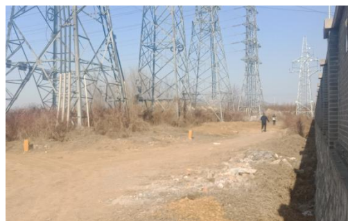
图 4-5 220kV 汇河站西侧
