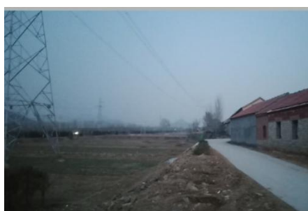
图 2-8（2）220kV 城汇线 70#~72#， 线西 13m，青石桥村民房
