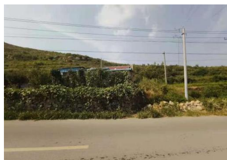
图 2-16 220kV 城汇线 21#~22#， 线西 12m，青杨行村民房
