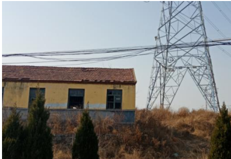
图 2-28 (1) 220kV 城鹏线 24#~25#， 线下，北张家庄村闲置房屋
