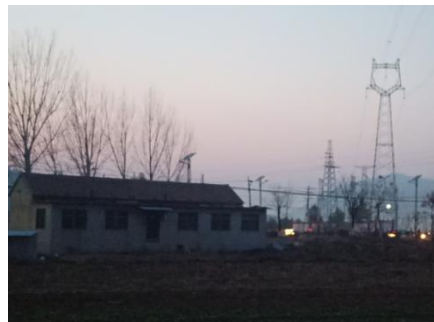
图 2-8（1）220kV 城汇线 70#~72#， 线西 13m，青石桥村民房
