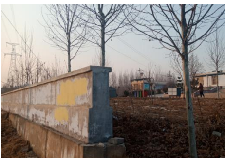
图 2-15 220kV 城汇线 41#~42#， 线北 40m，长勺小学传达室
