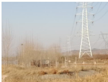
图 2-7 220kV 城汇线 97#~98#， 线西 13m，大增家庄看护房
