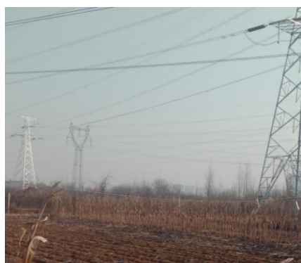
图 2-20 (1) 220kV 城汇线 3#~5#， 线下，大洛庄村看护房
