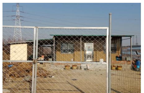
图 2-23 220kV 城鹏 II 线 7#~8#， 线南 25m，崔梁坡村看护房
