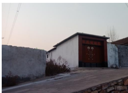
图 2-10 220kV 城汇线 61#~62#， 线南/线北 2m，下毛家圈村民房/看护房
