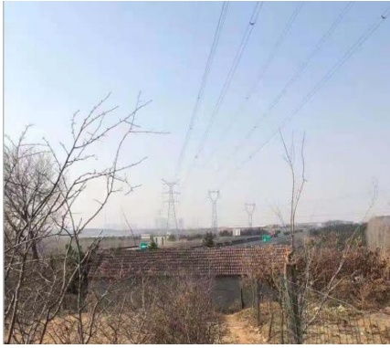
图 2-25 220kV 城鹏线 12#~13#， 线南 1m，杨家庄村民房
