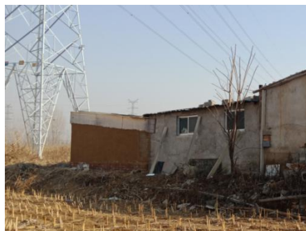
图 2-22 (2) 220kV 城鹏线 1#~2#， 线南 30m，王梁坡村看护房
