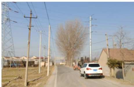
图 2-3（1）220kV 城汇线 105#~106#， 线东 28m，大增家庄民房/厂房
