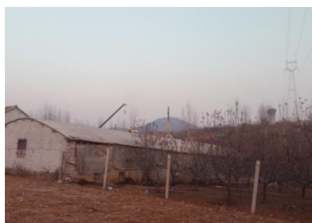
图 2-12 220kV 城汇线 47#~48#， 线北 22m，陈林村民房/看护房
