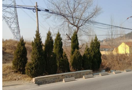
图 2-28 (2) 220kV 城鹏线 24#~25#， 线东 27m，义石园销售处
