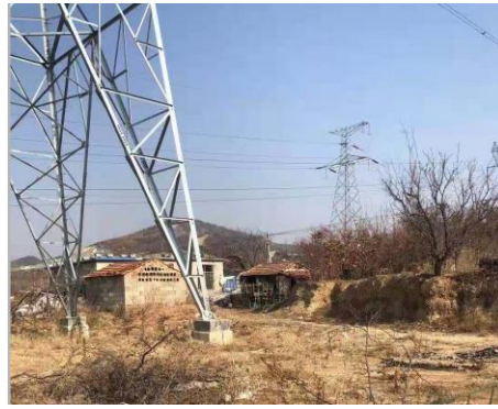
图 2-26 220kV 城鹏线 13#~14#， 线北 1m，杨家庄村看护房
