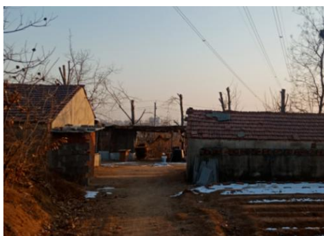
图 2-18 (1) 220kV 城汇线 12#~13#， 线下，北于家庄村看护房
