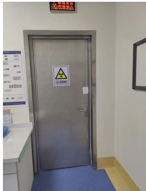
工作人员出入防护门
