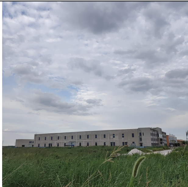
多频雷达站3东南侧约450m东营广元生物科技股 份有限公司
