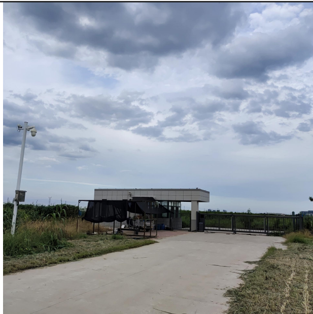
多频雷达站3东侧约150m处门卫室1
