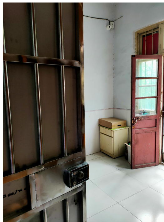
探伤机贮存室室外监控
