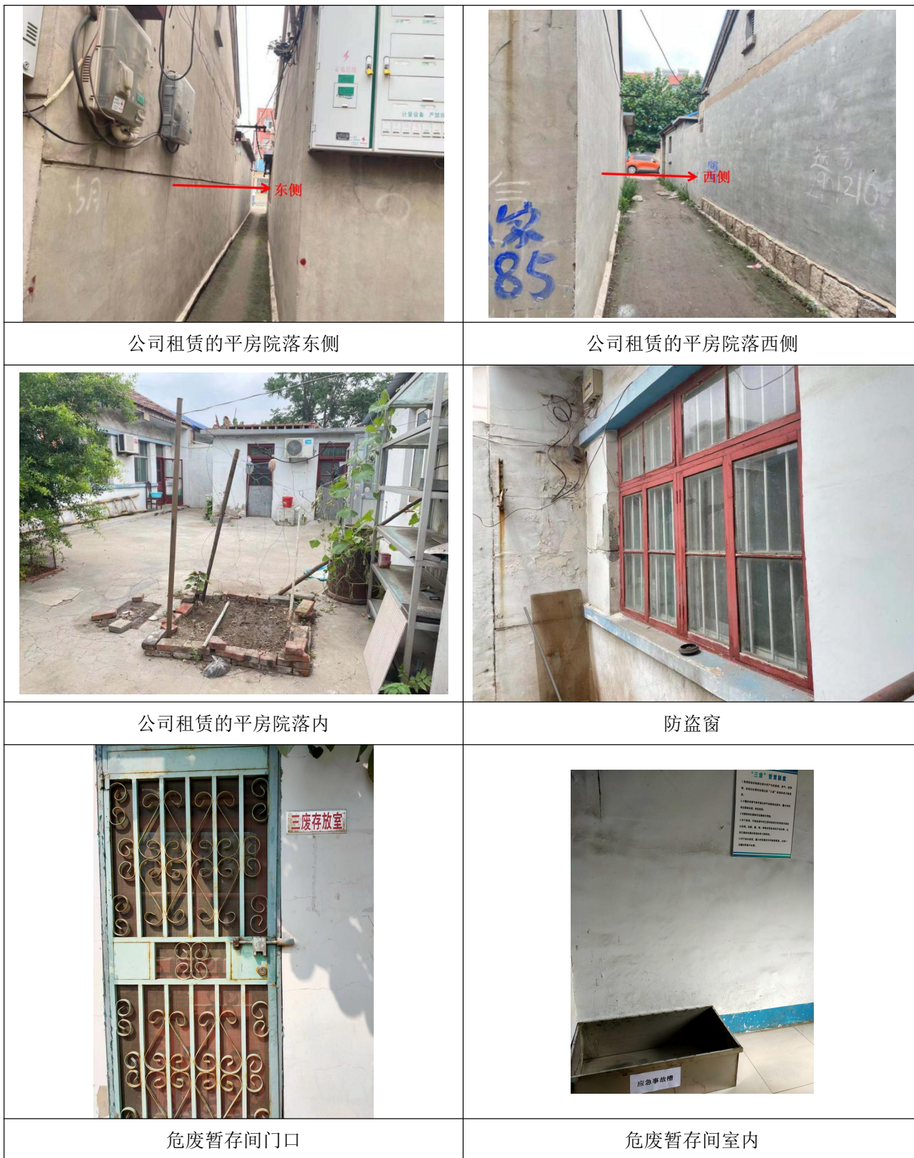
图 4-4 现场拍摄照片
