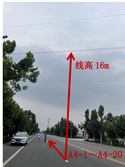
图7-4 220kV佛高线5#~6#、单回架空线路，向东北衰减，线高16m
