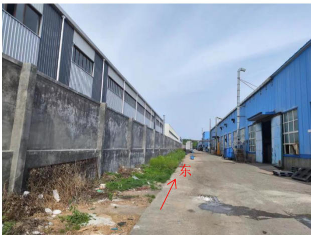
厂区内北侧道路
