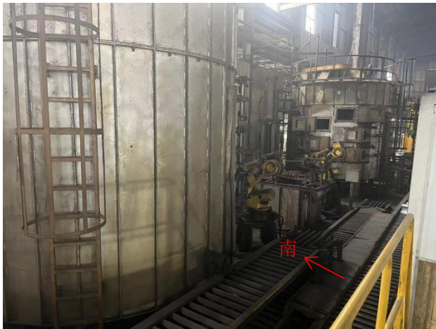
检测室南侧车间现状
