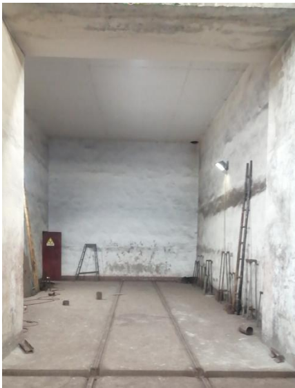
探伤室内现状
