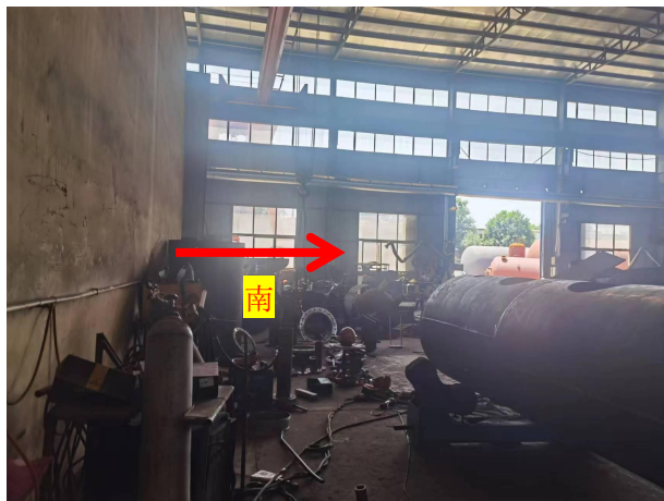
探伤室南侧区域现状
