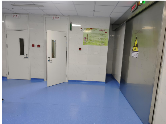
医用加速器机房西侧
