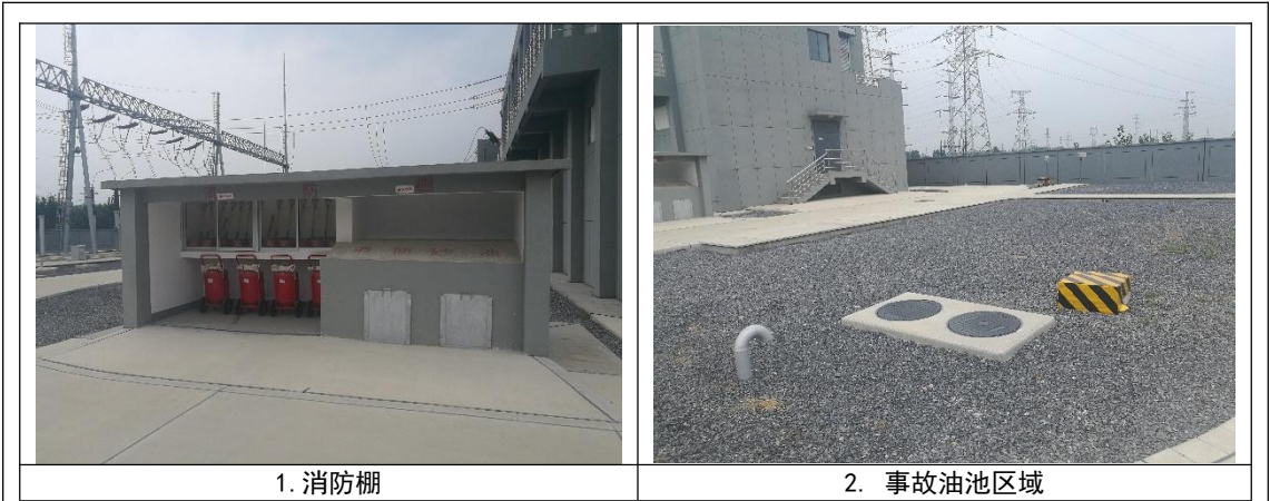
图 6-1 本工程安全环保措施执行情况现场照片
