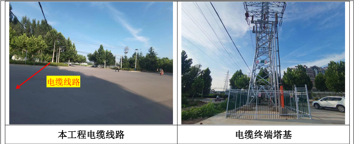
图 4-1 110kV 输电线路周围现场照片（拍摄于 2023 年 7 月）
