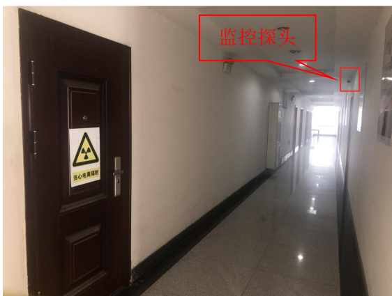
设备间外走廊监控探头
