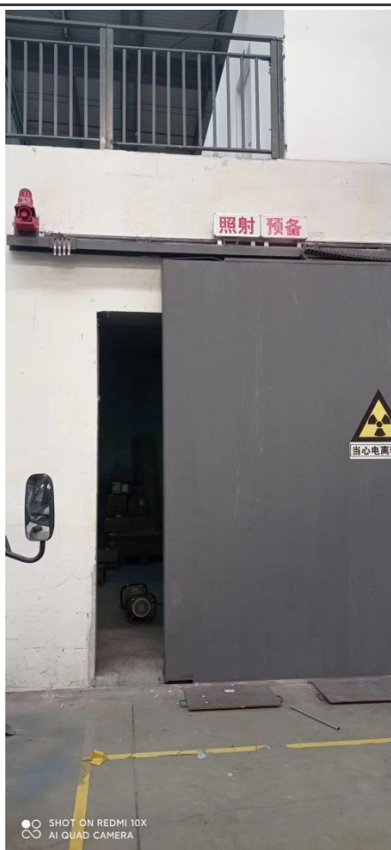
本项目探伤室外观
