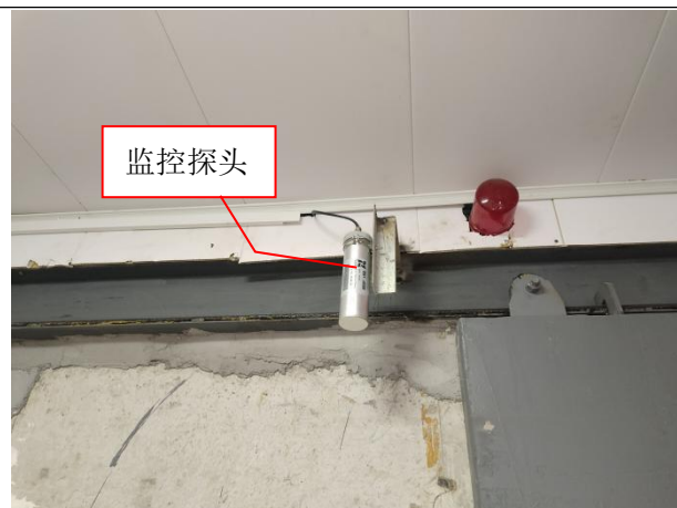
HF5000 型固定式辐射监测报警仪剂量探头
