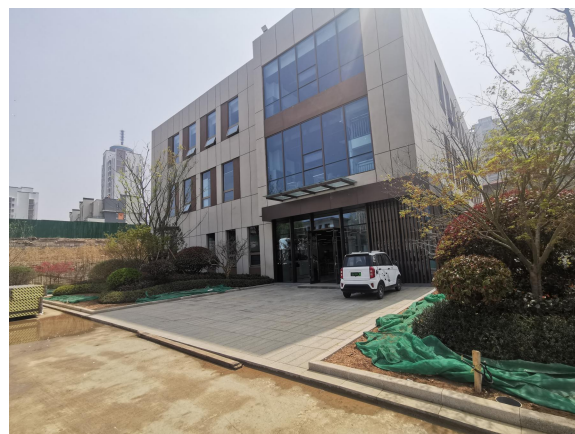
本项目南侧食堂
