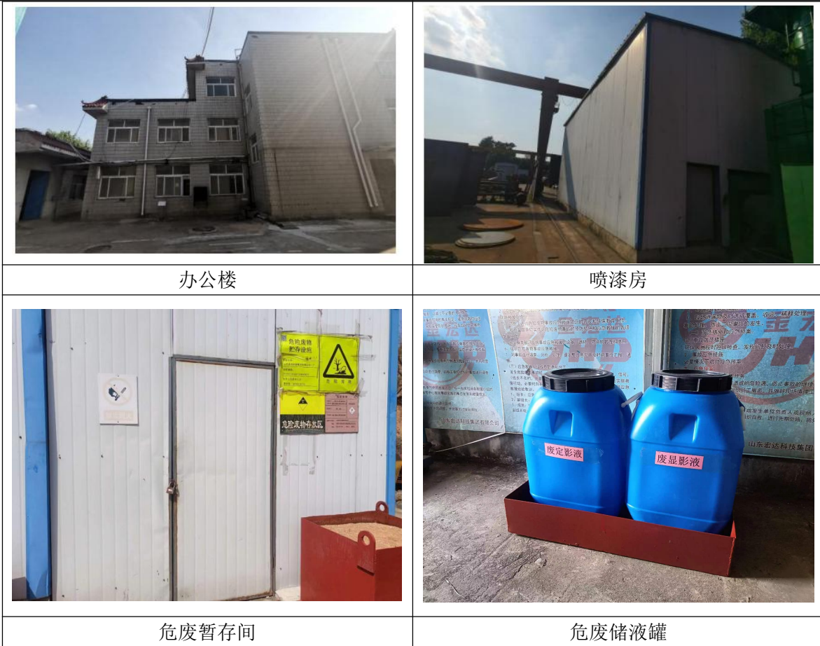
图 2-2 本项目现状照片
