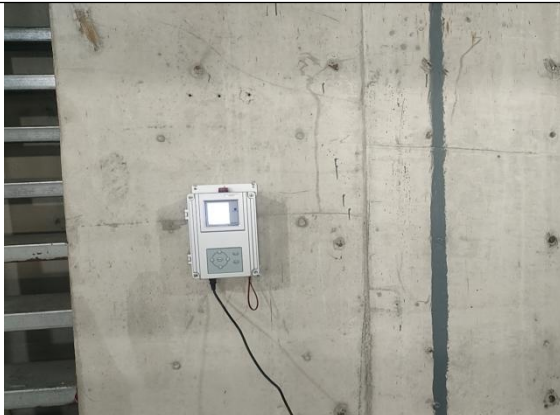
固定式场所辐射探测报警仪
