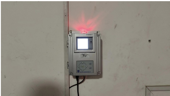
固定式辐射剂量检测仪显示屏
