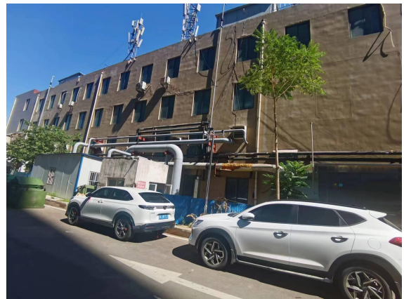
明湖热电厂锅炉房
