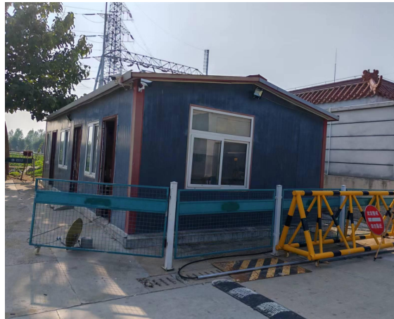
图 2.6-1 站址南侧 2.5m 岱宗 500 千伏变电站门卫
