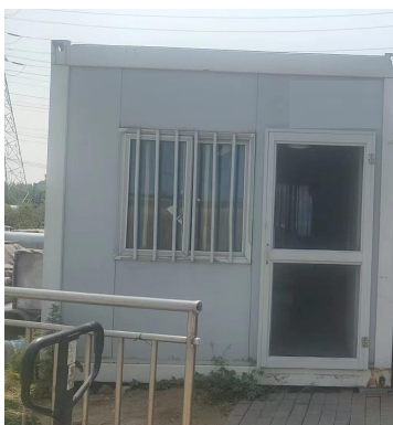
图 6.2-7 临时办公室临时占地恢复情况
