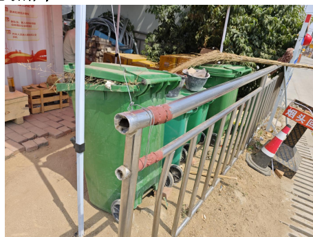
施工变电站外临时办公区生活垃圾桶
