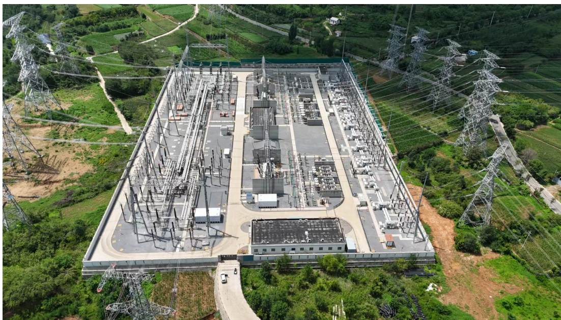
图 3.1-2 蟠龙 500 千伏变电站俯瞰图
