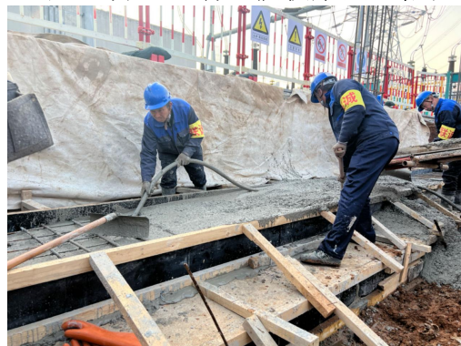
采用商品混凝土现场施工照片
