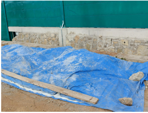
土方加盖篷布措施
