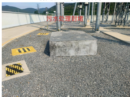
站内污水处理设施内污水清运后封堵
