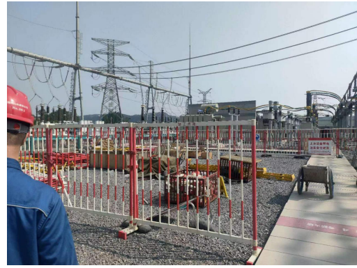
设置施工区域
