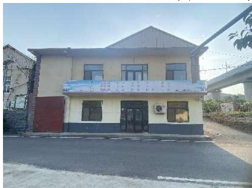
施工营地照片（南宅科村民房）
