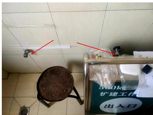
生活间上下水管封堵
