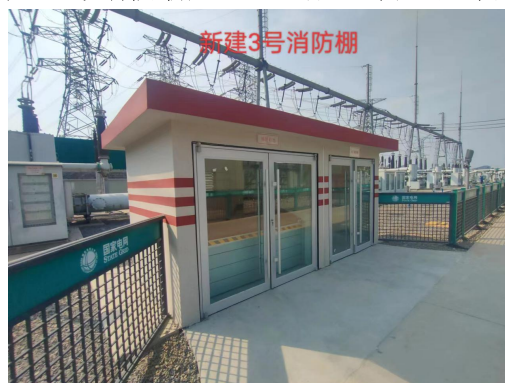
新建 3 号消防棚(220kV 配电装置区域)
