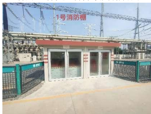
新建 1 号消防棚(500kV 配电装置区域)
