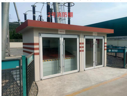
新建 2 号消防棚(500kV 配电装置区域)
