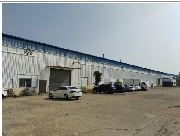
上药控股山东有限公司泰安分公司车间
