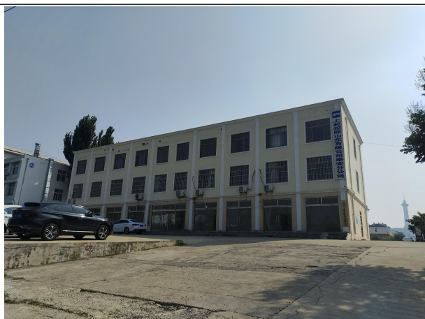
上药控股山东有限公司泰安分公司办公楼
