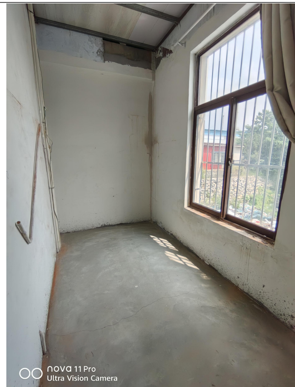
贮源库楼上空置房间
