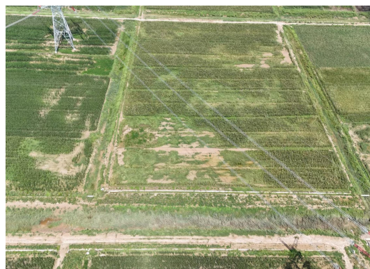
图 5.3-3 塔基拆除及复耕情况
