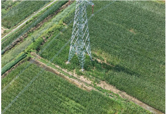
兴青线、兴寿线 4 号塔基
