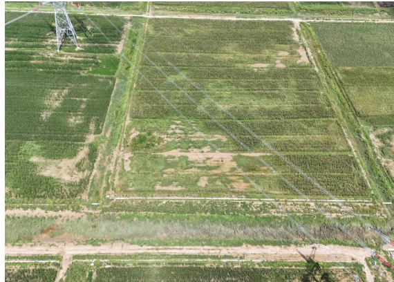
图 6.2-5 塔基拆除及复耕情况
