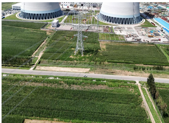
兴青线、兴寿线 1 号塔附近施工便道
