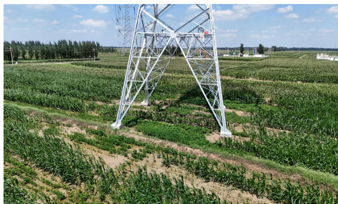
兴青线 6 号、青油线 117 号塔基
