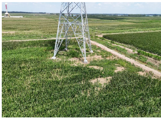
兴寿线 6 号塔基
