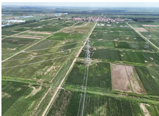
兴寿线 6 号塔基附近
