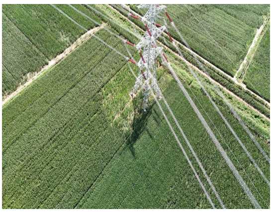
兴青线、兴寿线 2 号塔基
