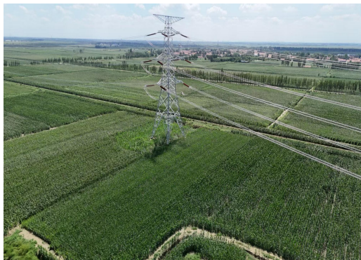
线路塔基下方恢复情况
