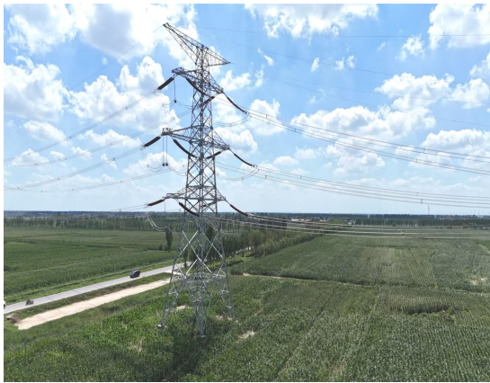
兴青线、兴寿线 1 号塔基
