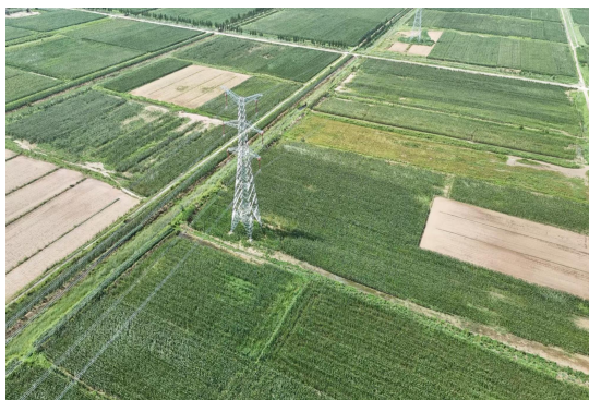
兴青线、兴寿线 4 号塔附近施工便道
