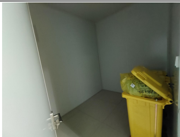
西侧污物暂存间
