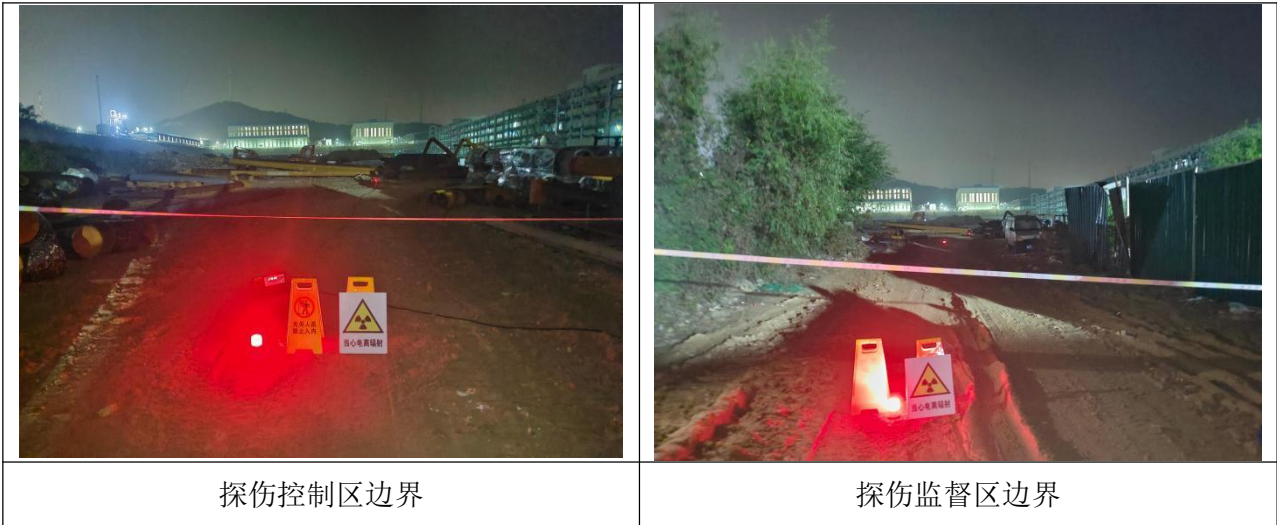
图 7-1 检测现场照片
