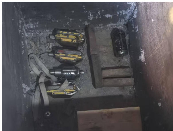
图 2-5 本项目贮源坑现状
