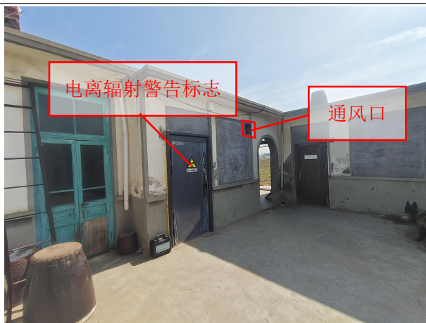
贮源库西侧院内空地
