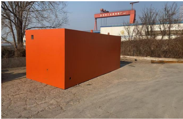
现有探伤室现状
