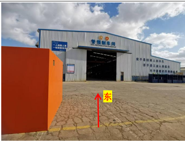
探伤室东侧区域现状
