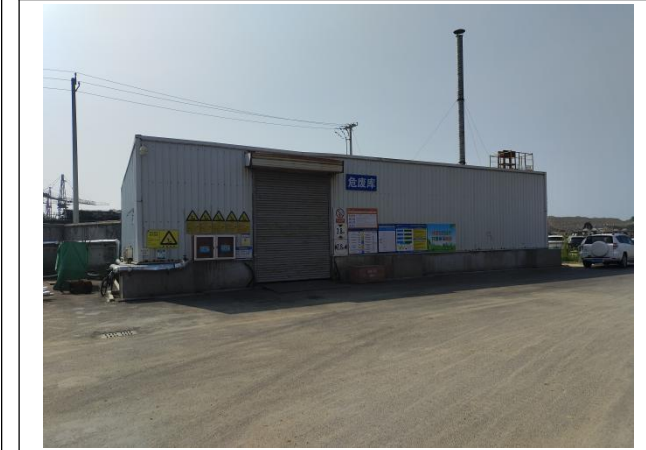
友联修船（山东）有限公司危废库
