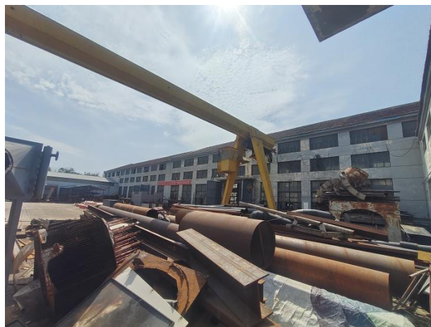
公司铆焊车间
