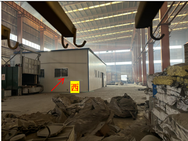
拟建探伤室西侧区域现状
