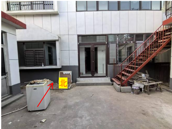
拟建设备间北侧（院内空地、办公楼 2F）
