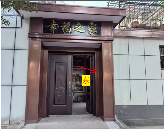
拟建设备间东侧（大门）
