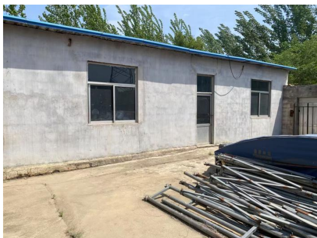
危废暂存间现状
