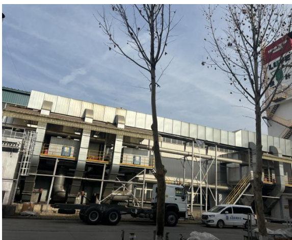
探伤北侧总装喷漆车间
