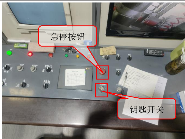
X 射线实时成像检测系统内 门洞北侧自带急停按钮
