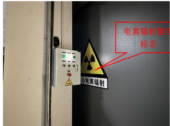
防护门外侧门控开关
