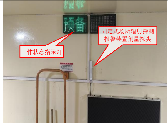
固定式辐射探测报警装置剂量探头
