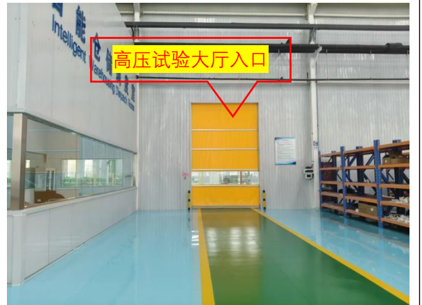
X射线实时成像检测系统东侧高压试验大厅入口
