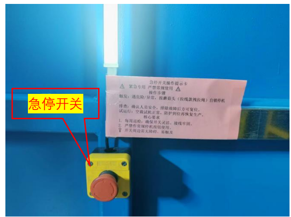
X射线实时成像检测系统内急停按钮
