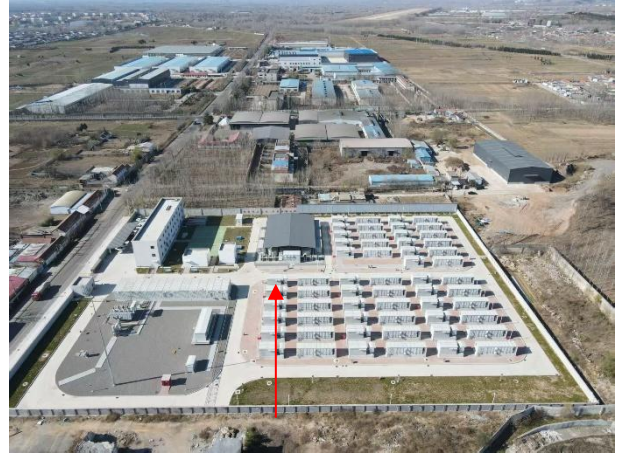
拟建 220kV 储能电站西侧
