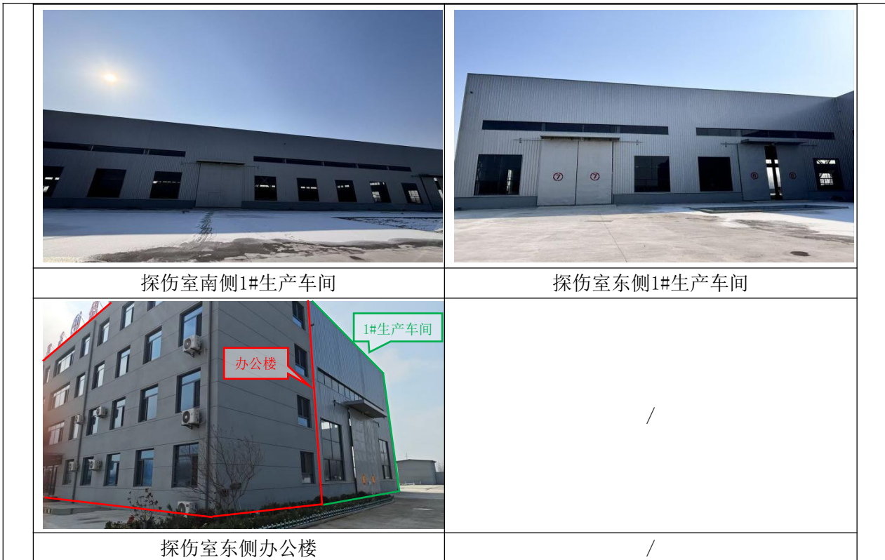
图 2-2 本项目现状照片（拍摄于 2026. 1）
