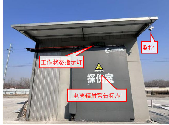
探伤室南侧防护门
