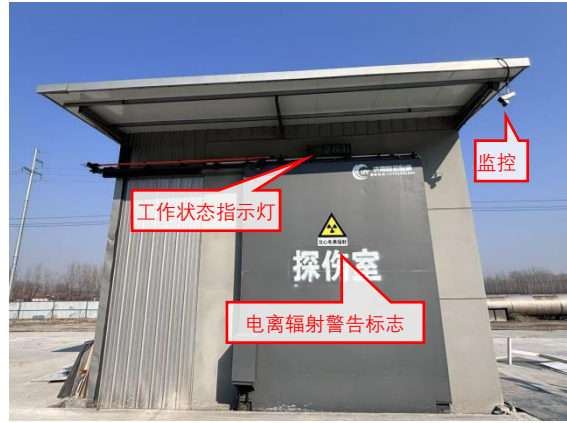
探伤室南侧防护门
