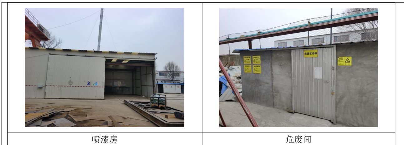
图 2-2 本项目现状照片
