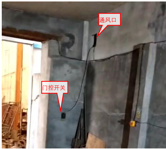
探伤室西墙通风口
