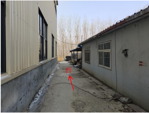
拟建探伤室西侧区域现状
