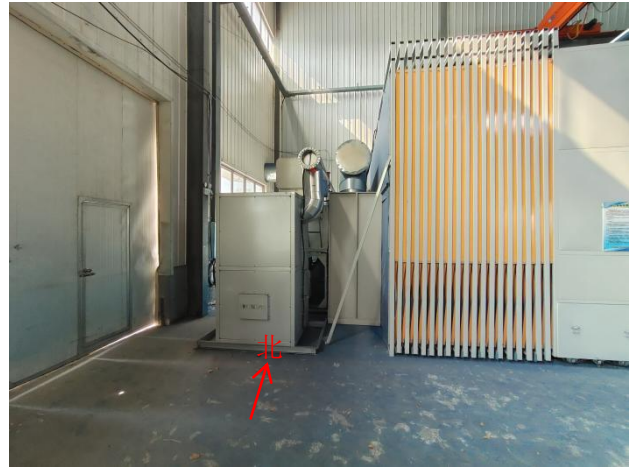
拟建探伤室西侧区域现状
