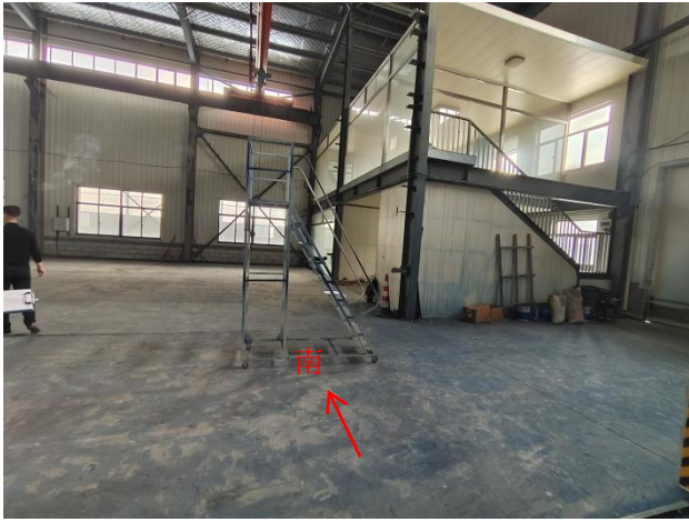
拟建探伤室南侧区域现状
