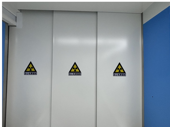
DSA 复合手术室东侧防护门（防护门外为 CT 放置区）
