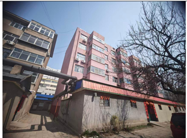
潍坊市第三人民医院家属楼
