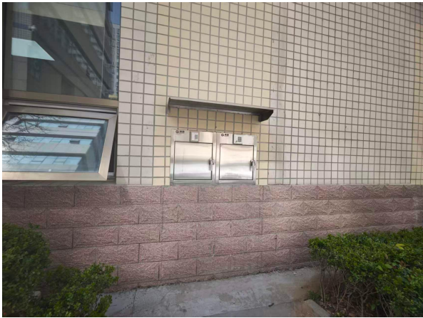
储源室北墙窗口
