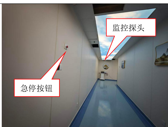
迷道内急停按钮、监控探头
