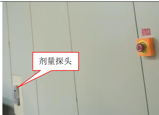
固定式辐射探测报警仪剂量探头
