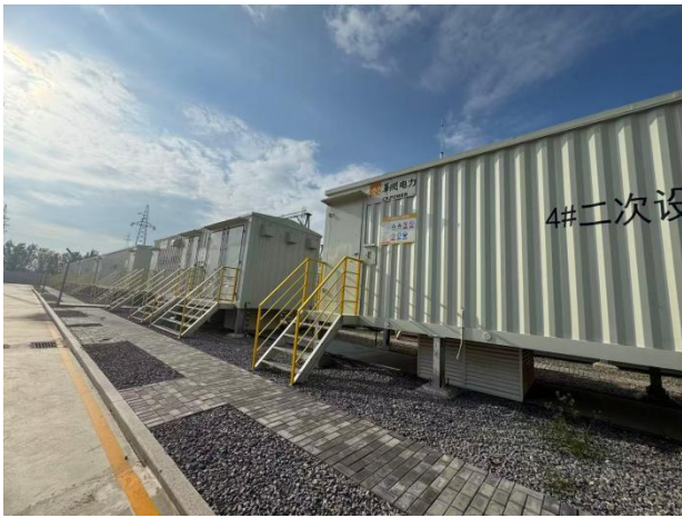
35kV 配电装置预制舱
