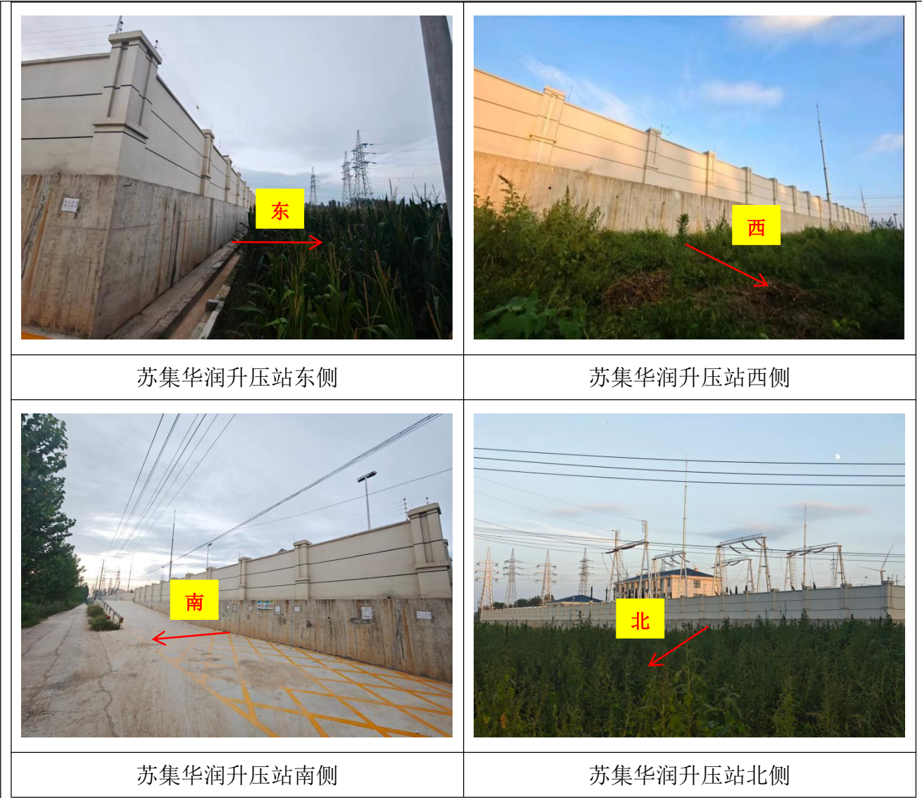
图 4-1 升压站周围情况现场照片（拍摄于 2026 年 8 月）
