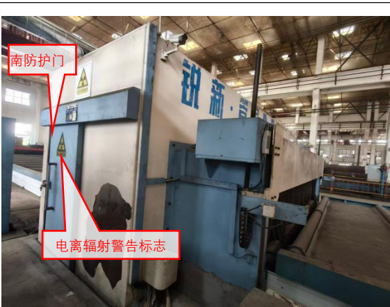
X射线实时成像检测系统南侧
